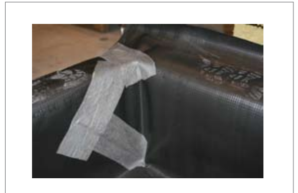
Eksempel på hjørneløsning med DELTA® Than og DELTA® Flexx-band
